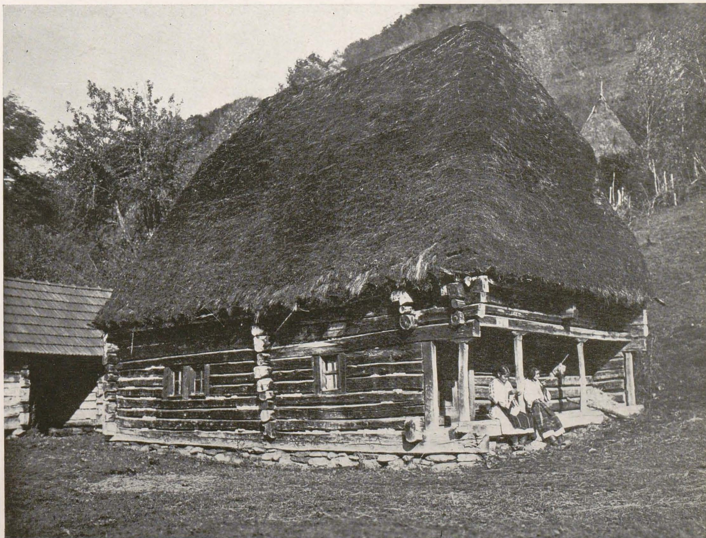
83. Sistem de îmbinare a birnelor «în cheo- toare dreaptă» la o casă din Țara Hațegului.
